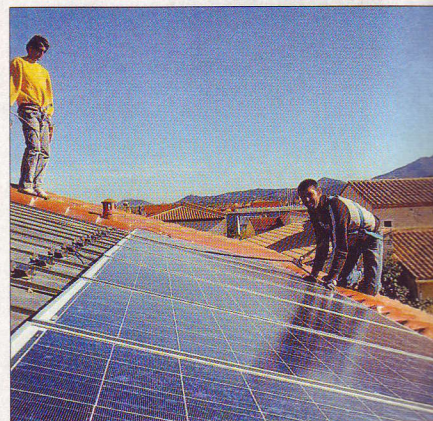
L'installation de panneaux solaires, un marché très porteur sur le territoire de Montpellier Agglomération.
